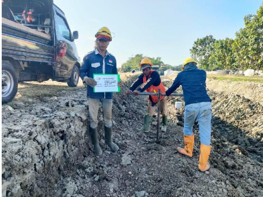
HB -3 (Handbore 3) Pekerjaan Penyelidikan Tanah Rehabilitasi Jaringan Irigasi Daerah Irigasi Glapan Tahap II Paket 1 Lokasi Kab. Grobogan dan Kab. Demak
