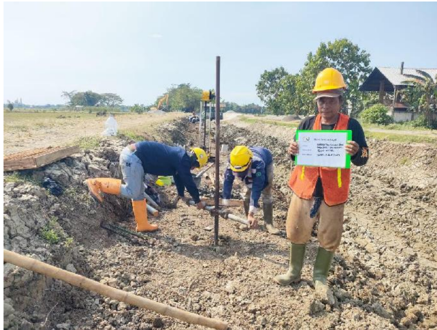
HB-1 (Hanbore 1) Pekerjaan Penyelidikan Tanah Rehabilitasi Jaringan Irigasi Daerah Irigasi Glapan Tahap II Paket 1 Lokasi Kab. Grobogan dan Kab. Demak
