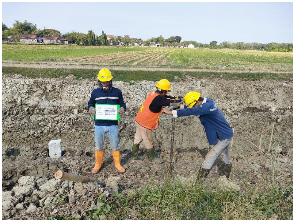
HB -2 (Handbore 2) Pekerjaan Penyelidikan Tanah Rehabilitasi Jaringan Irigasi Daerah Irigasi Glapan Tahap II Paket 1 Lokasi Kab. Grobogan dan Kab. Demak
