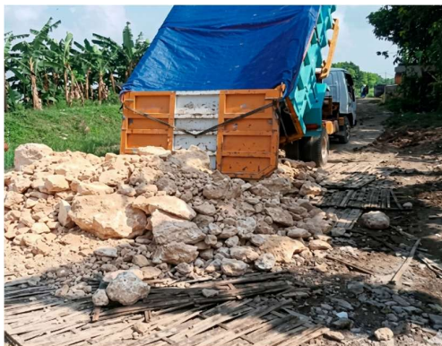
Gambar 5. Penggunaan matras bambu dan penimbunan limestone (sumber: hasil dokumentasi penulis, 2024)
