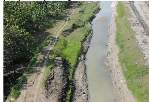
Gambar 1. Kondisi eksisting tanggul saluran. (sumber: dokumentasi penulis, 2024)
