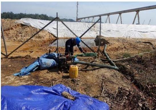
**Gambar 4.** Pemompaan air buangan ke saluran pembuangan
