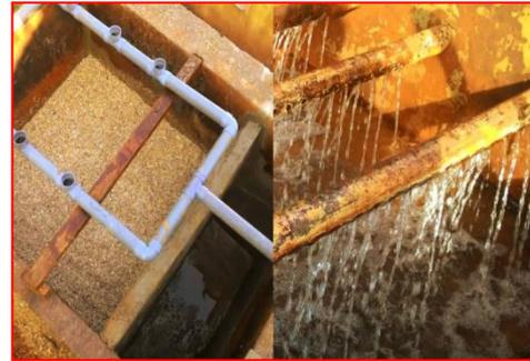
**Gambar 2.** Prinsip kerja aerasi tirai air
