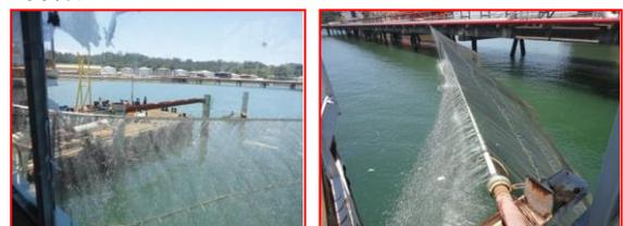
**Gambar 6.** Alat paranet water fire screen setelah terpasang dan difungsikan
