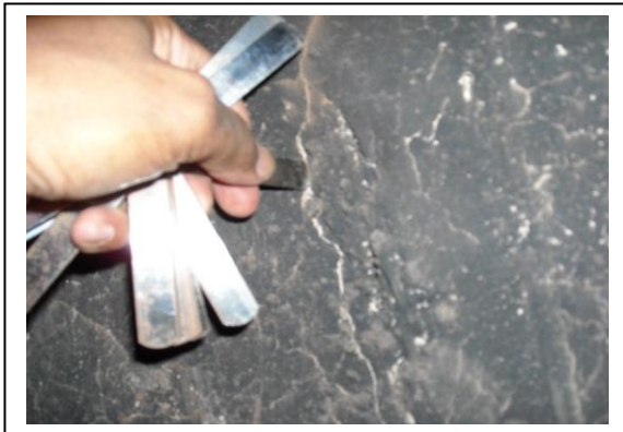
Gambar 1. Retak garis arah vertikal keatas dan kebawah
