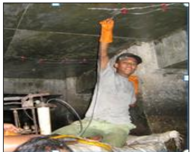
Gambar 7. Injeksi retak dengan LPI
