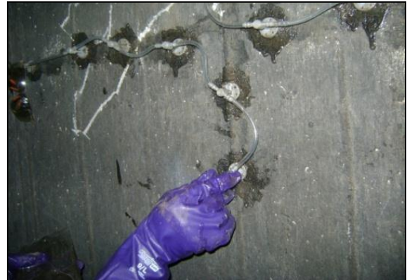
Gambar 6. Pemasangan packer port set
