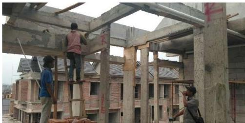
**Gambar 4.** Perbaikan pada beton yang keropos
