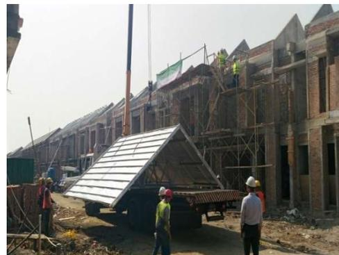
**Gambar 5.** Pemasangan penutup atap
