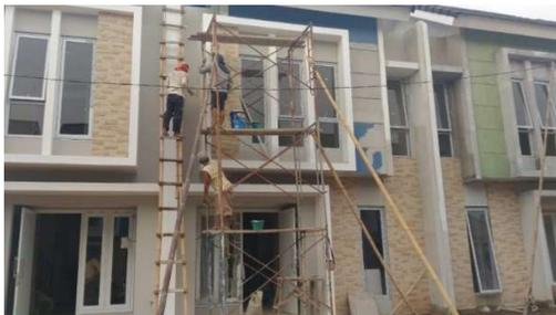
**Gambar 6.** Pengecatan bagian luar rumah
