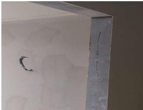
**Gambar 6.** Dinding beton untuk pemasangan kusen yang tidak sesuai ukuran
