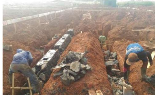
**Gambar 3.** Pemasangan pondasi batu kali
