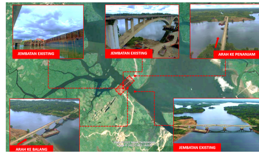
Gambar 3.1 Lokasi pembangunan duplikasi jembatan pulau balang bentang pendek Sumber: Penulis (2024)
