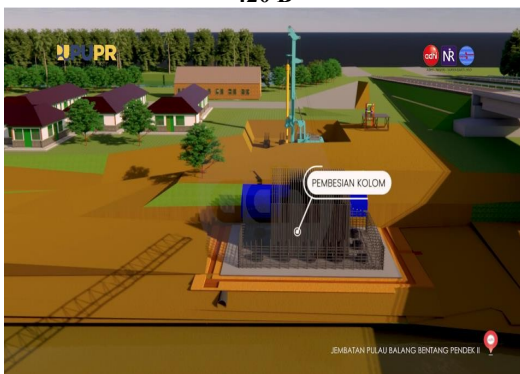
Gambar 3.9 Pekerjaan Pembesian Kolom
