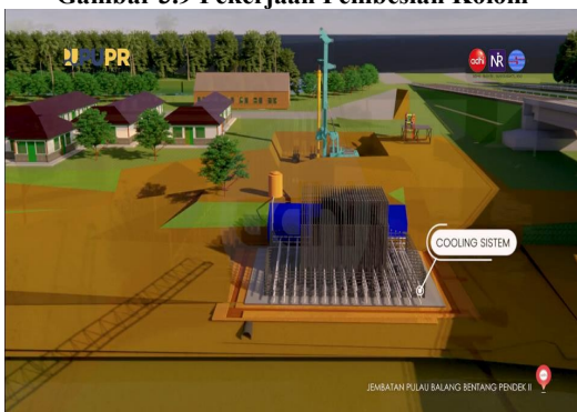
Gambar 3.10 Pemasangan pipa PVC untuk Cooling System
