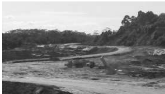
Gambar 2. Kondisi Aktual Jalan Akses Segmen Jalan Tikungan
