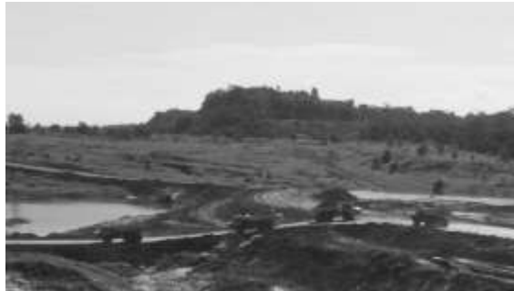
Gambar 3. Kondisi Aktual Jalan Akses Segmen Kemiringan Jalan
