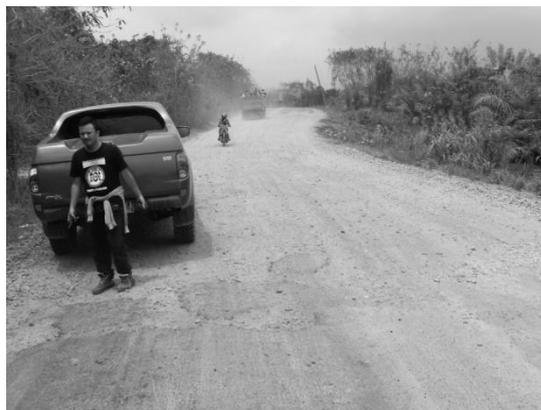
**Gambar 13.** Potensi *slump* di badan jalan pada batulempung yang bersisipan dengan batupasir, difoto ke arah utara
