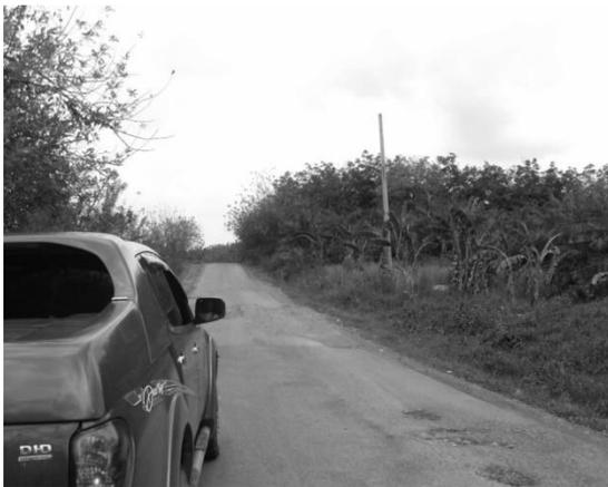
**Gambar 14.** Kenampakan tiang listrik yang miring akibat adanya *creep*, difoto ke arah selatan
