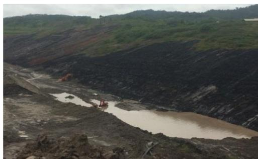
**Gambar 1.** Kondisi Pit S12GN yang tergenang akibat air limpasan permukaan
