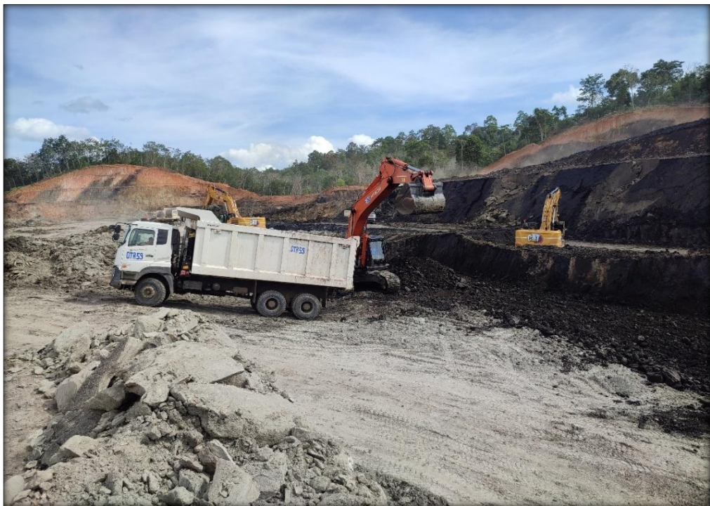
Kegiatan loading batubara dari excavator ke dump truck PIT selatan
