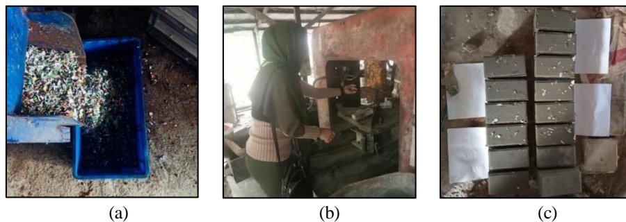
Gambar 2. (a) Pencacahan Sampah Plastik Multilayer ; (b) Pencetakan Paving Block ; (c) Pengeringan Paving Block
