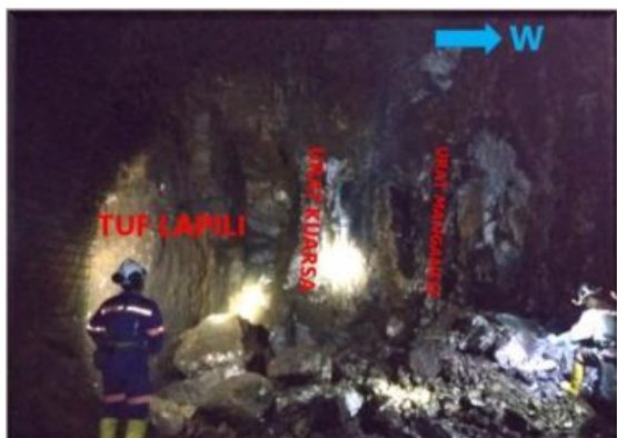
Gambar 5. Kondisi massa batuan Terowongan Kubang Cicau 536.
