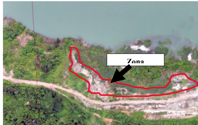
Gambar 11 Lereng pada Section 7 drone IPD Pit 1
