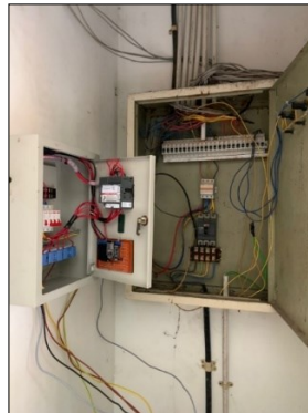
Gambar 2 Penempatan pada panel listrik
