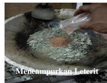
Gambar 2. Memasak Agregat dan Mencampur *Filler Laterit*
