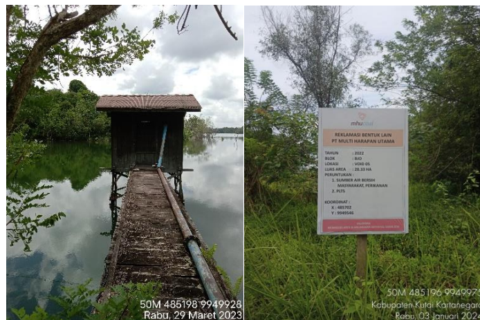
Gambar 2. Kondisi void PT MHU
